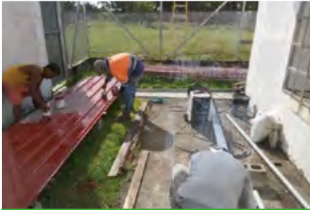
Mantenimiento y reemplazo de techos
