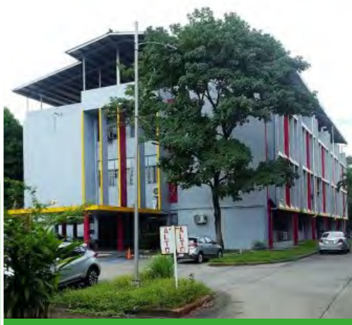
Mantenimiento de la pintura externa del Edificio del Instituto Especializado de Análisis
