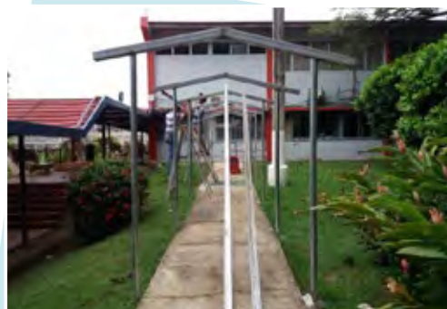
Construcción de rampas y colocación de techo para uso de personas con discapacidad
