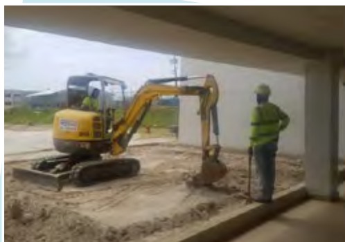
Realización de trabajos de relleno y colocación de grama en la parte frontal del edificio de la Extensión Universitaria de Arraiján
