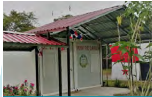
Cobertizo, piso y vereda construido en la sede de la UTED
